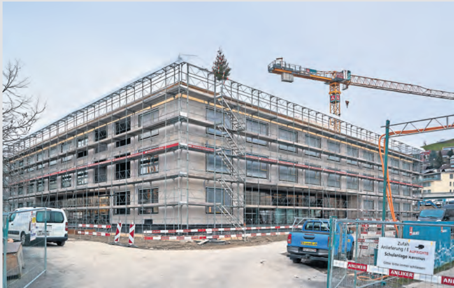
Das Pflegezentrum ist im Rohbau vollendet. Die Alterswohnungen werden Ende Jahr bezugsbereit sein.
