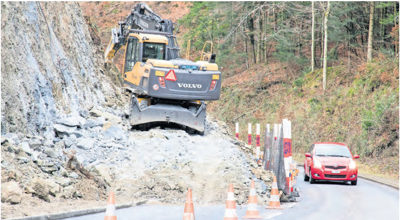
An der Meggerstrasse schreiten die Bauarbeiten plangemäss voran.
