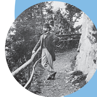
Bau der Stanserhornbahn. Das Bild zeigt den Erbauer, Franz Josef Durrer-Bucher, auf dem Felsenweg auf dem Stanserhorn.
